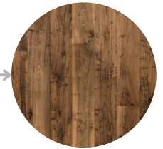
ESTRUCTURA TECHO DE MADERA
